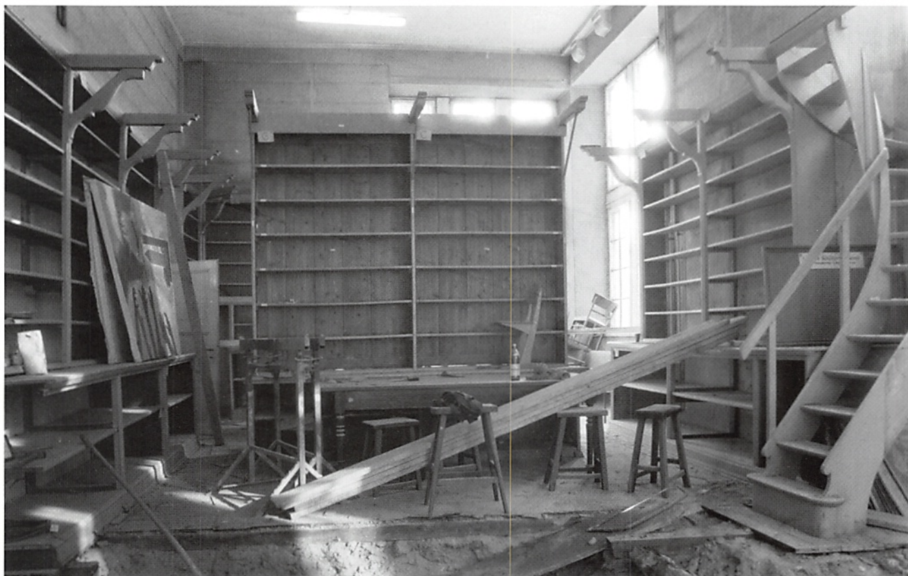
Der Bibliotheksraum während der Renovierungsarbeiten (Foto R. Köhne)
